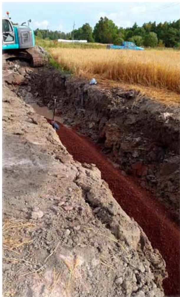
Ny vattenledning i Finström
