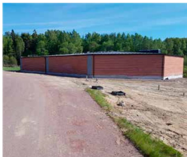
Ny lågreservoar vid vattenverket togs i bruk juni 2017.
