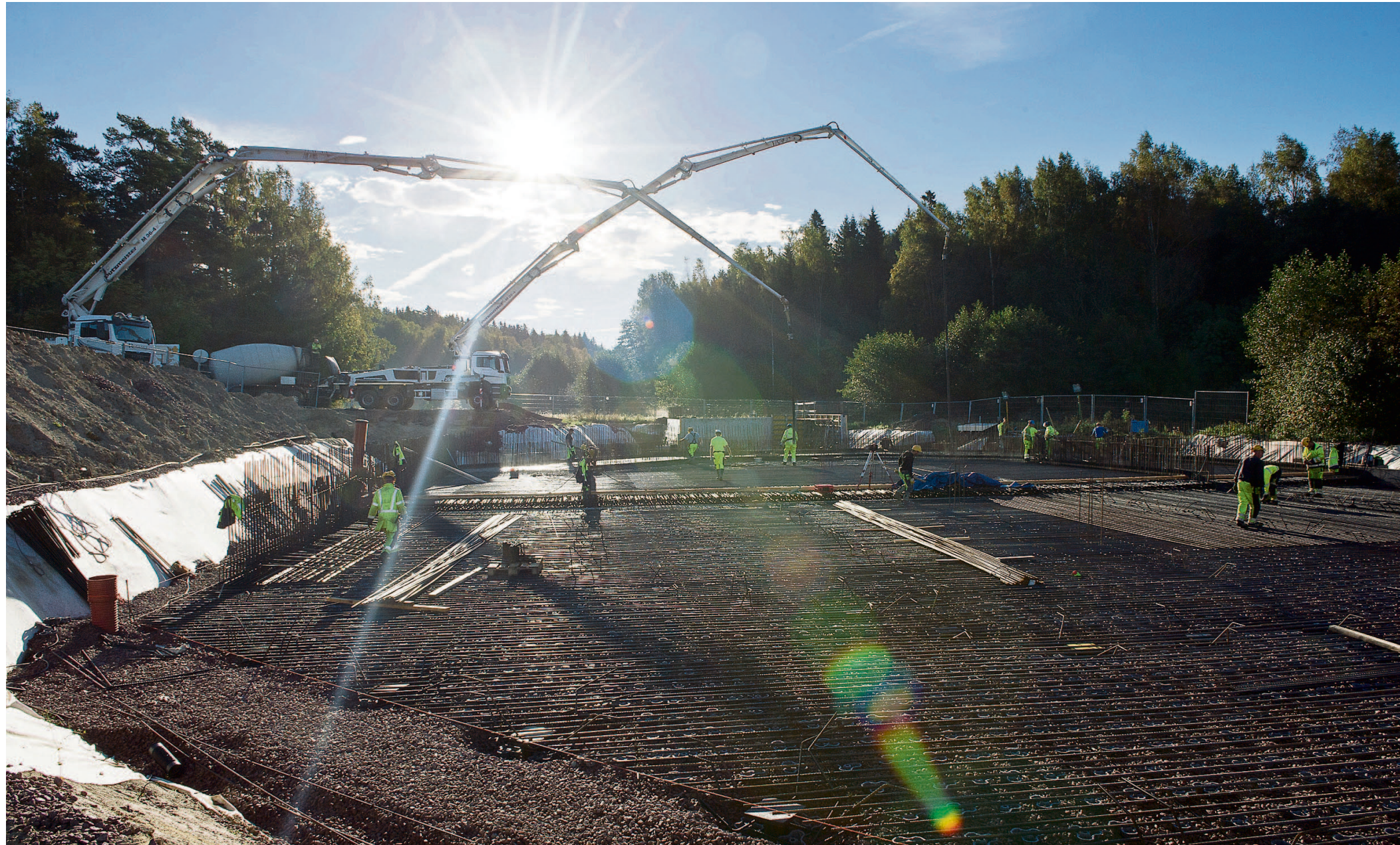
Rafaels är på plats för att gjuta plattan. Allt ska vara vattentätt, för det är plattan och byggnadens väggar som blir själva bassängen.
