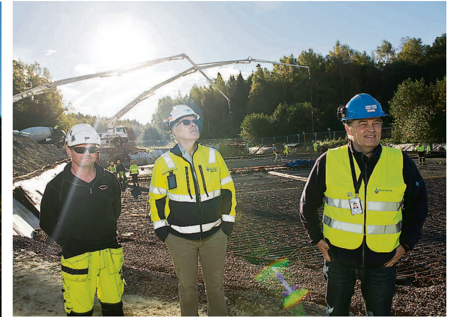
Med ett års byggtid ska den nya vattenreservoaren stå klar i juni 2017. Från vänster platschef Patrik Jörgensen från Hans Mattsson Ab, Ålands vattens planeringsingenjör Gottfrid Öhberg och vd Christian Nordas.
