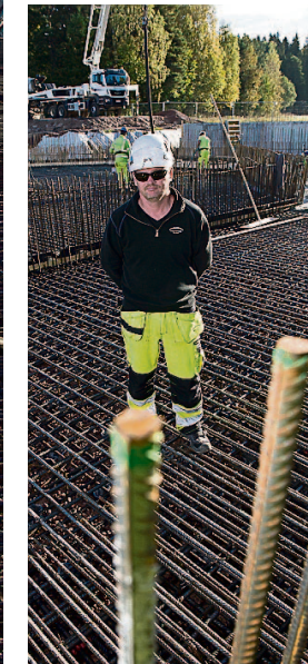
120 ton armering och 180 pålar finns i plattan. Patrik Jörgensen är platschef för bygget.
